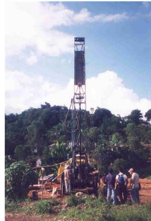
Construcción de pozo de agua en acuíferos Cretácicos kársticos de la Formación Cobán
